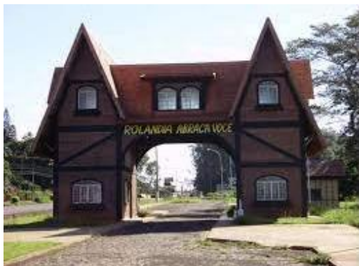
PORTAL DE ENTRADA DO MUNICÍPIO
